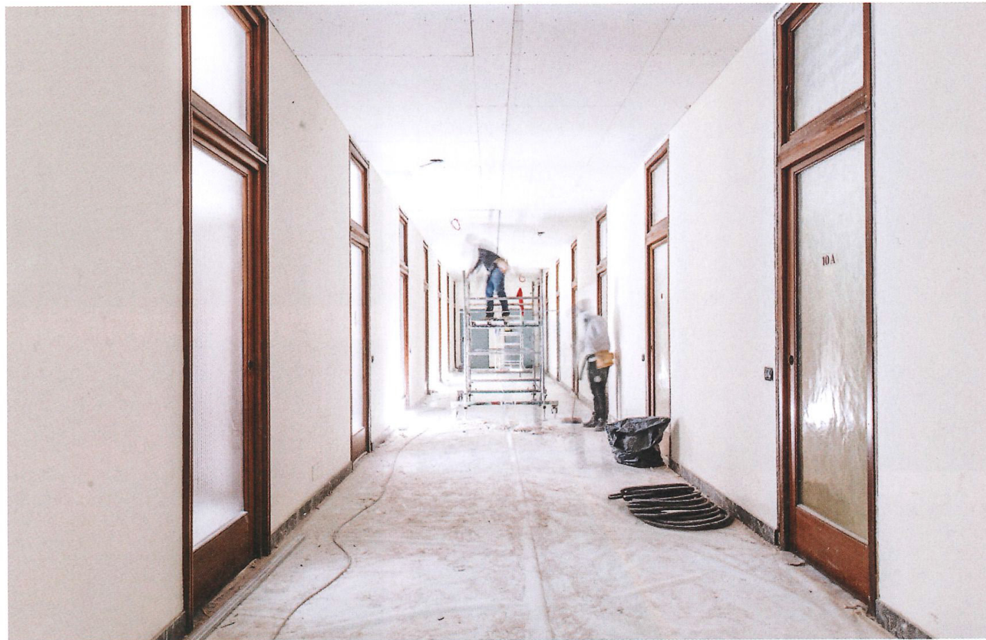
Opere di controsoffittatura del lungo corridoio distributivo nei vari piani
