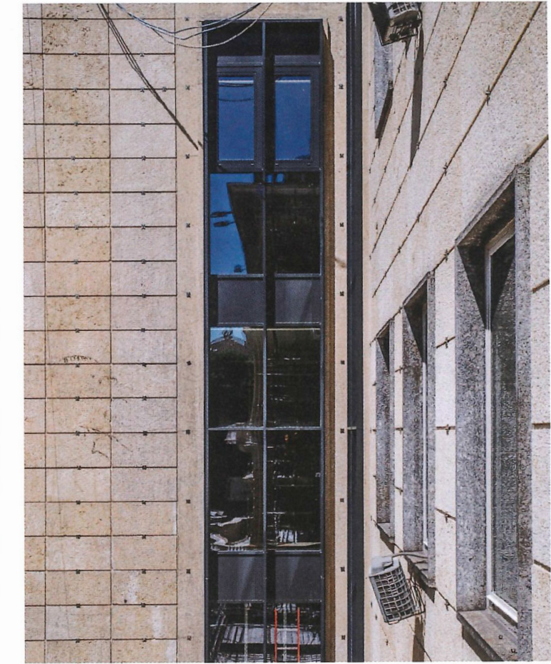
Vista dall'interno verso la nuova facciata vetrata. Al centro, perfettamente integrate nel disegno complessivo, le cornici delle ante apribili
