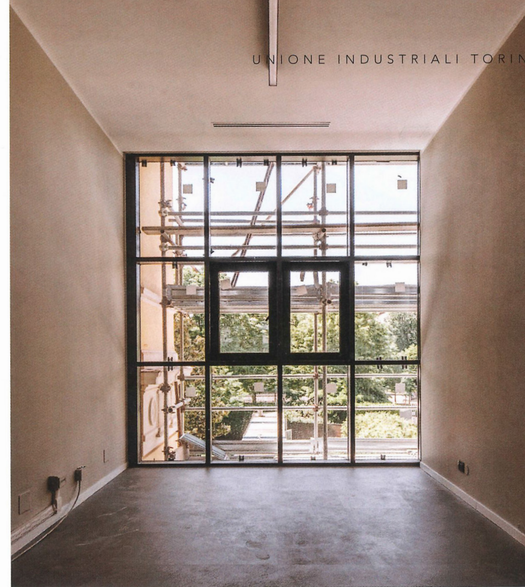
Immagini di dettaglio della posa della facciata vetrata
