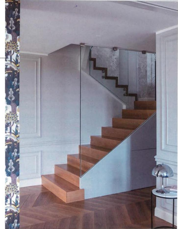
La **scala che porta al piano superiore** ha mantenuto la struttura esistente. Portata a nudo, gli scalini, pedate e alzate, sono stati rivestiti dello stesso legno di rovere del parquet e i parapetti sono stati rifatti in vetro. La stessa vetreria che si è occupata delle lastre del soppalco ha tagliato e fornito i parapetti: tutti i componenti sono stati tagliati a misura.
